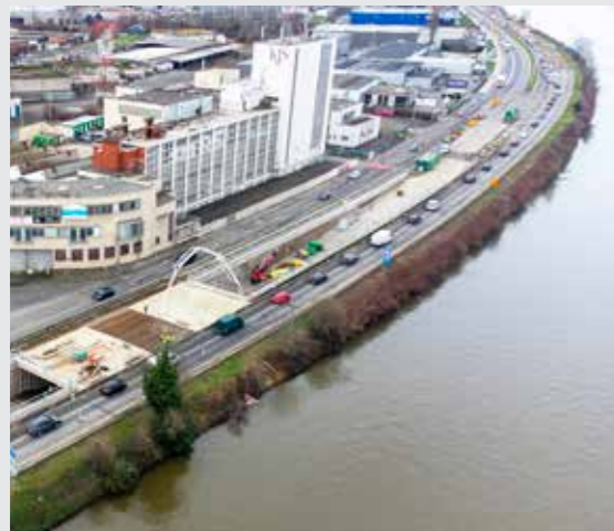
BRESSOUX. : TRANSFORMATION DE L'AUTOROUTE E25/A25 EN BOULEVARD URBAIN, À LIÈGE.
