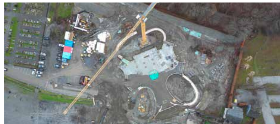
CONFORTI - LE TERRASSEMENT DU PARC À THÈME BARRYLAND, QUI METTRA À L'HONNEUR LES CHIENS SAINT-BERNARD A COMMENCÉ.
