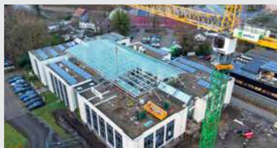
DÉMONTAGE DE LA VERRIÈRE.
