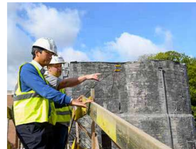
CHANTIER DE RECONSTRUCTION DES ARCHES DU PONT DES TROUS, À TOURNAI.
