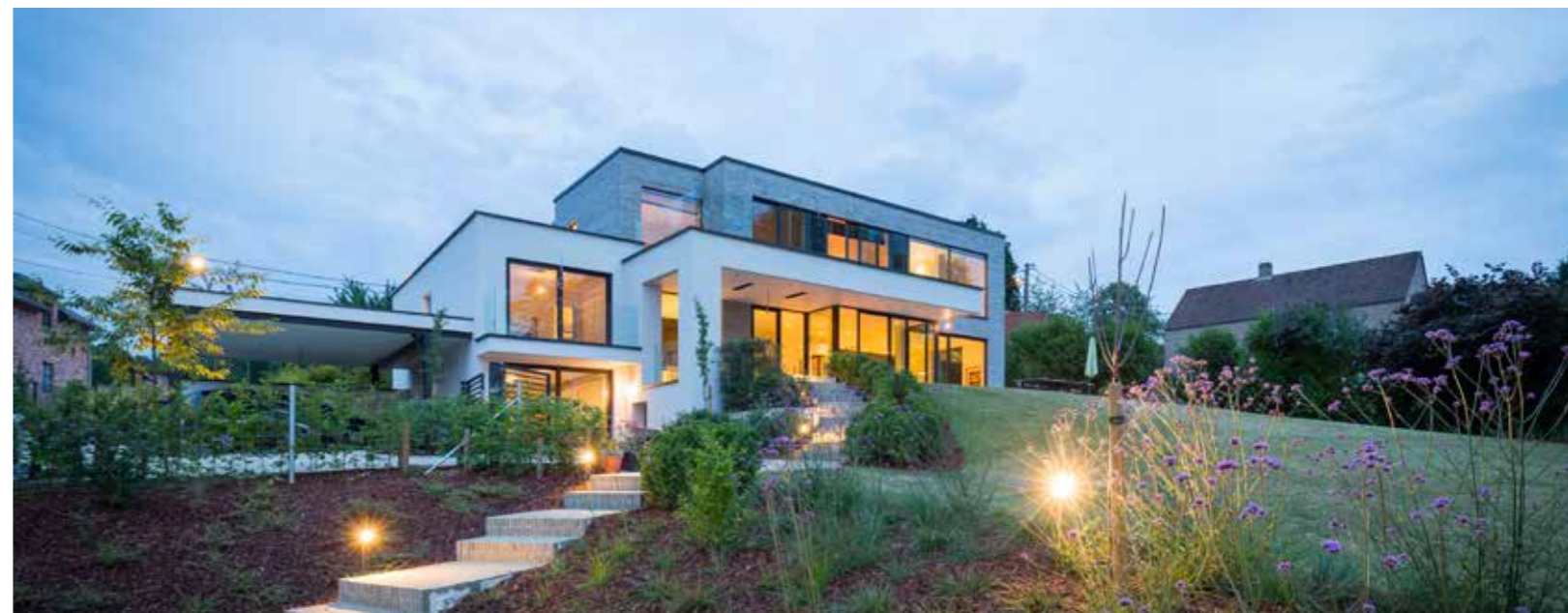
RÉNOVATION GLOBALE D'UNE MAISON UNIFAMILIALE.
